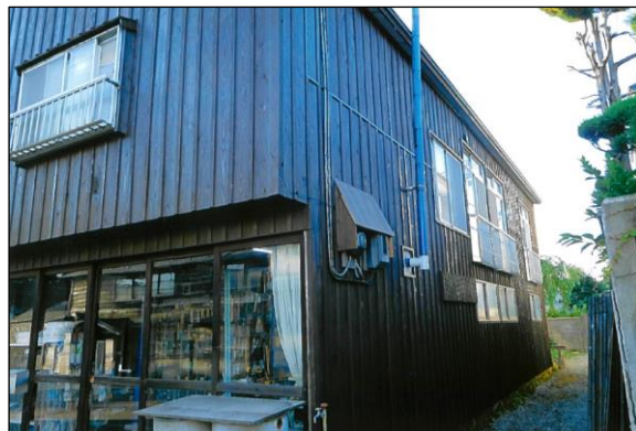
景観重点地区(増田地区)における建築物の補修【実施後】
