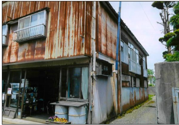
景観重点地区(増田地区)における建築物の補修【実施前】
