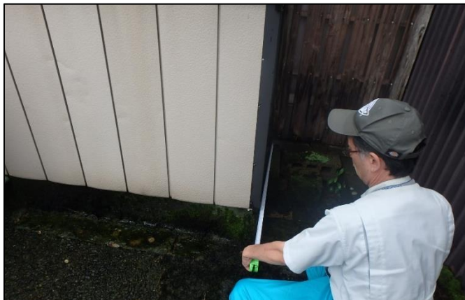
歴史的建造物現況調査状況 (8月28日)
