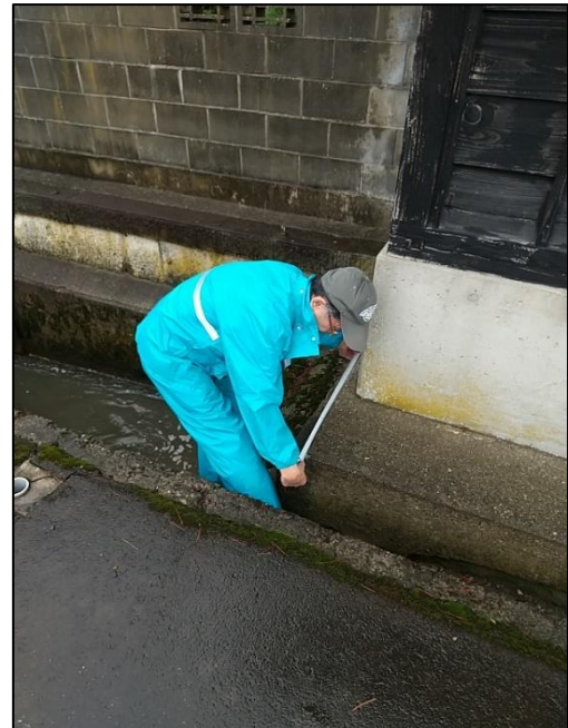
歴史的建造物現況調査状況 (8月28日)
