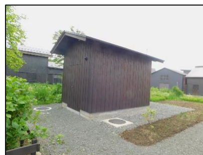
地下消火水槽・ポンプ室設置状況（重文佐藤家住宅）
