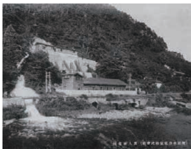
増田水電真人発電所（昭和 10 年頃）
