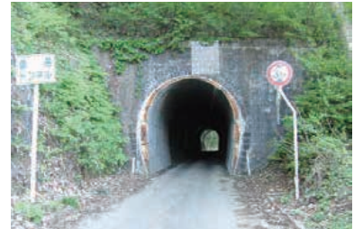
旧横荘線御岳隧道
