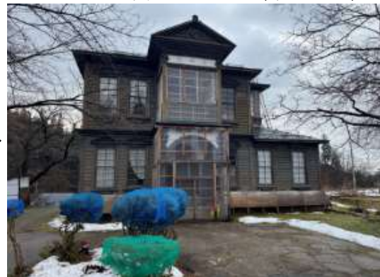
県指定有形文化財(建造物) 旧日新館 外壁塗装修理(※無色の塗料を使用) 実施前 実施後
