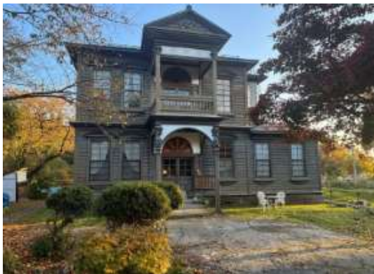
県指定有形文化財(建造物) 旧日新館 外壁塗装修理(※無色の塗料を使用) 実施前 実施後
