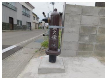
地上式消火栓の設置状況
