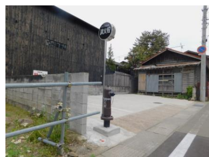
地上式消火栓の設置状況
