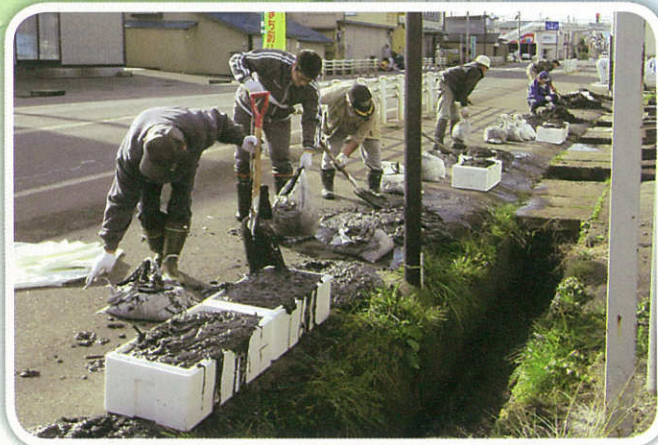
西上・西原の旧国道沿いの側溝
