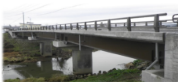
長寿命化改修工事が完了した「落合橋」
