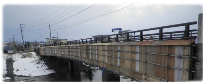
長寿命化改修工事が行われている「落合橋」
