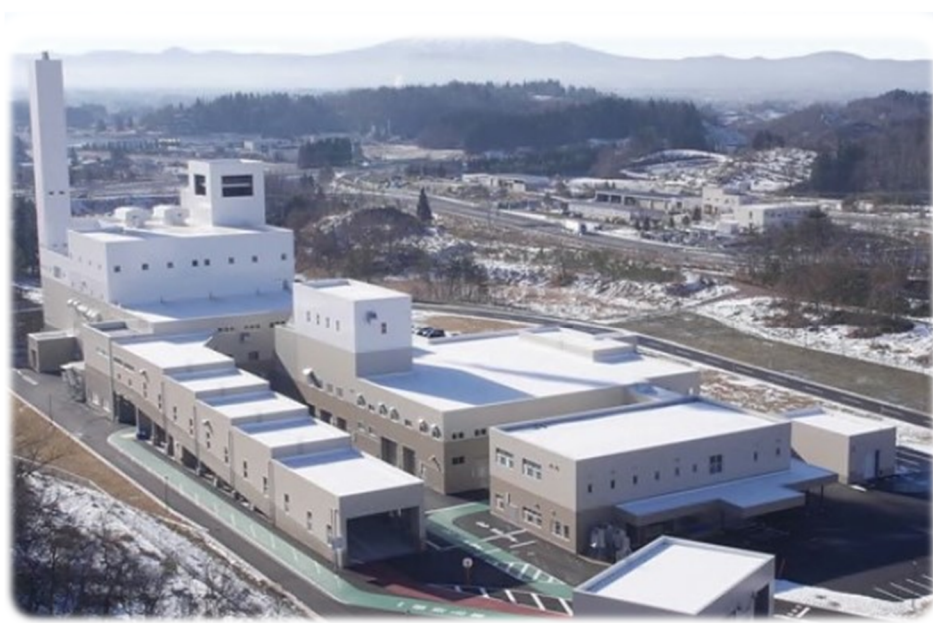
DBO方式で運用されている「クリーンプラザよこて」
