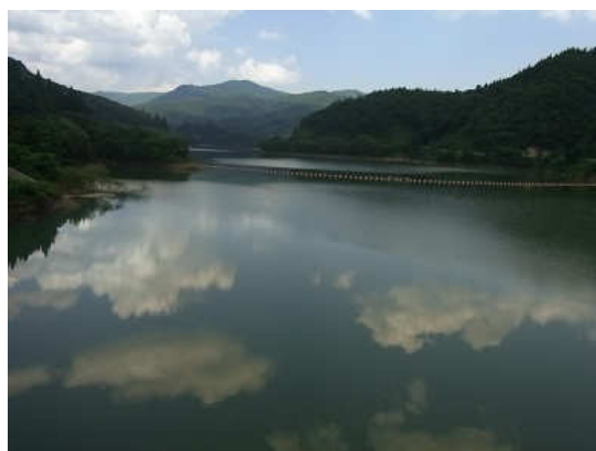
■大松川ダム（山内地域）
