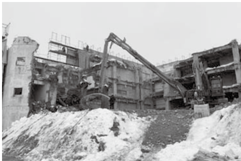
旧ユニオンビル解体（4年2月）
