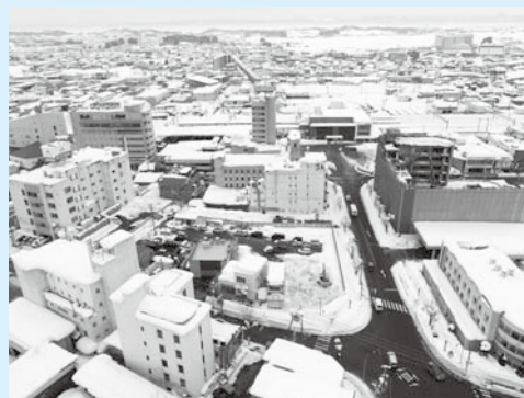
横手駅東口第二地区の除却・建築状況
