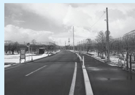
整備中の市道西下中の村線
