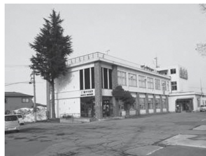
昭和35年建設の雄物川庁舎
