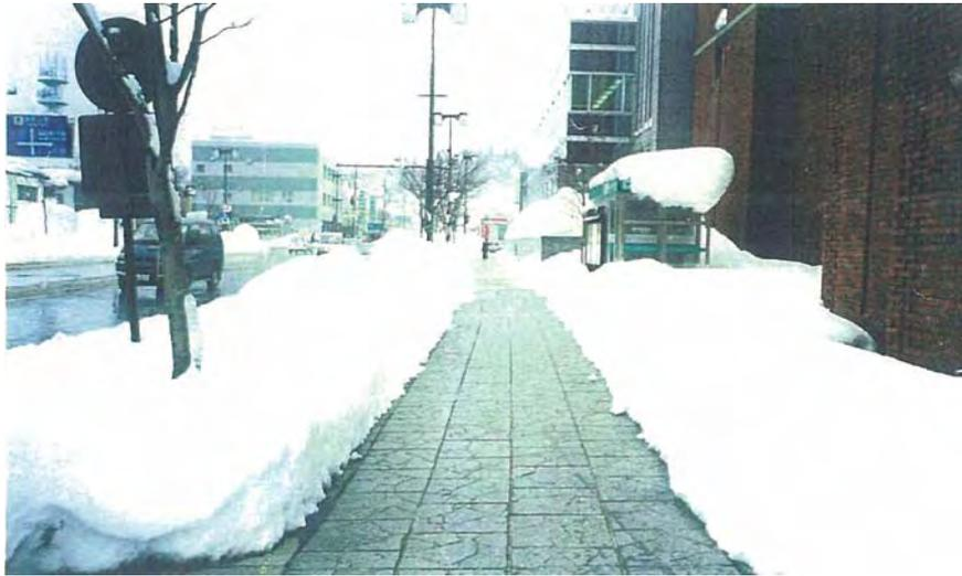
図 4-34 歩道へのロードヒーティング設置事例(横手市)
