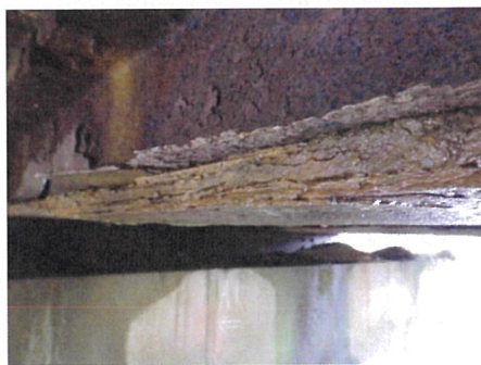
鋼桁の腐食
