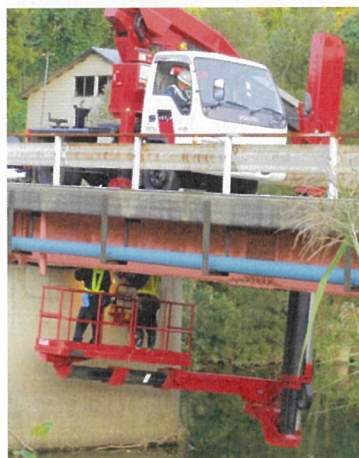
写真3.3 点検車による点検
