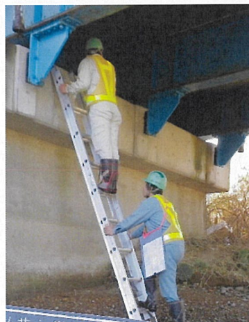
写真3.2 梯子による点検
