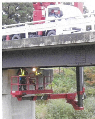
写真3.3 点検車による点検
