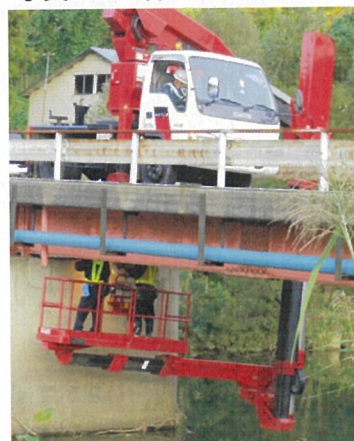
写真3.3 点検車による点検
