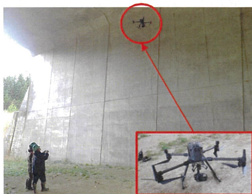
ドローンによる点検状況
