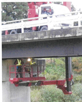
写真3.3 点検車による点検
