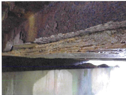
鋼桁の腐食
