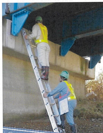
写真3.2 梯子による点検
