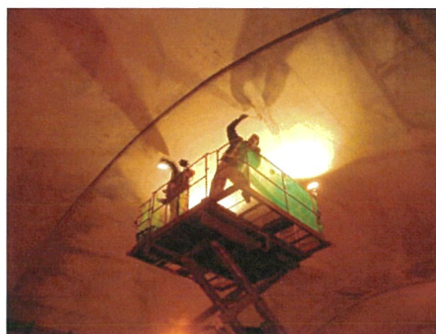
写真3.2 打音検査作業状況
