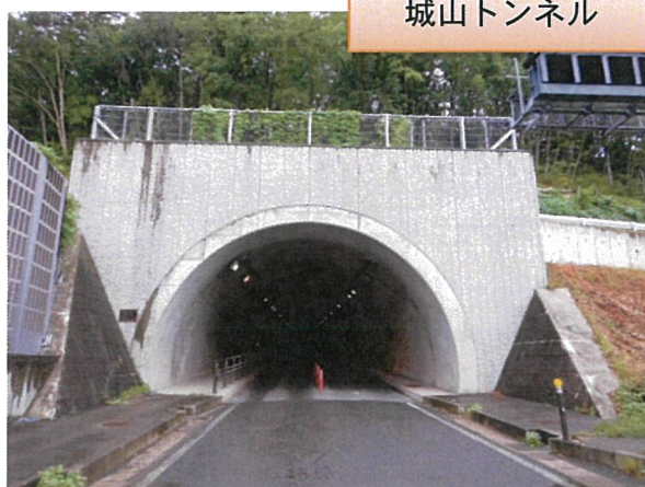
城山トンネル
