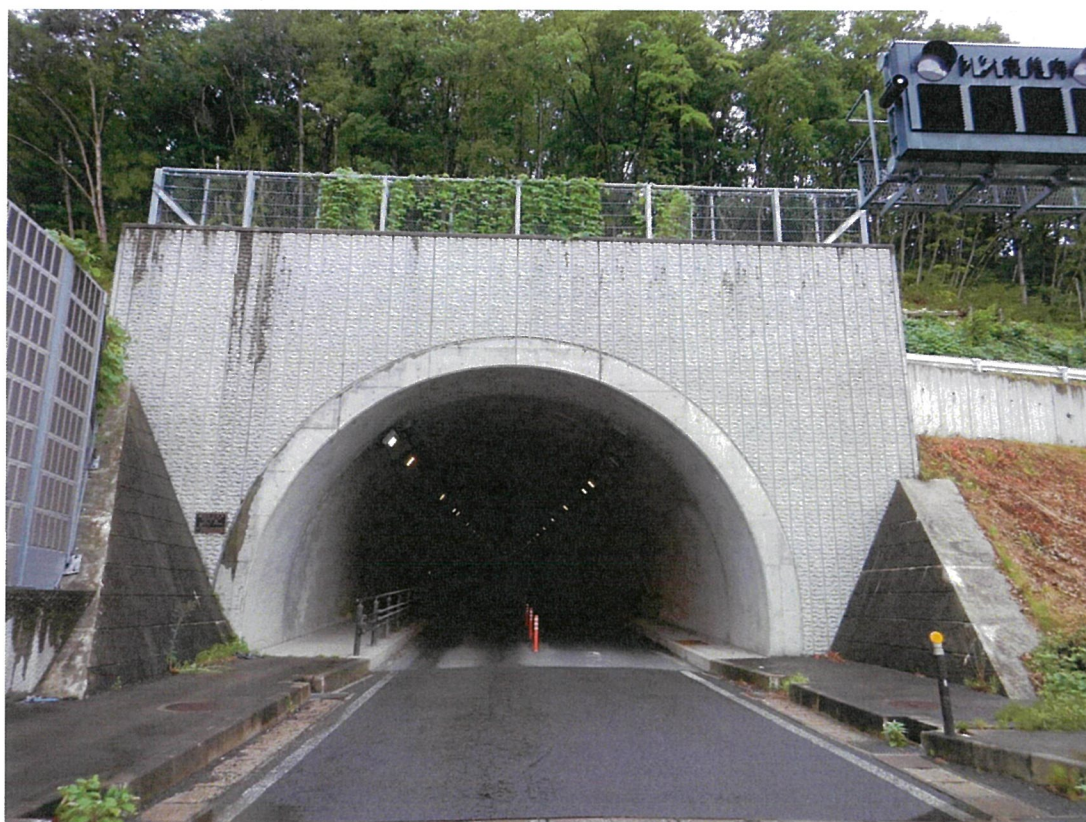
城山トンネル
