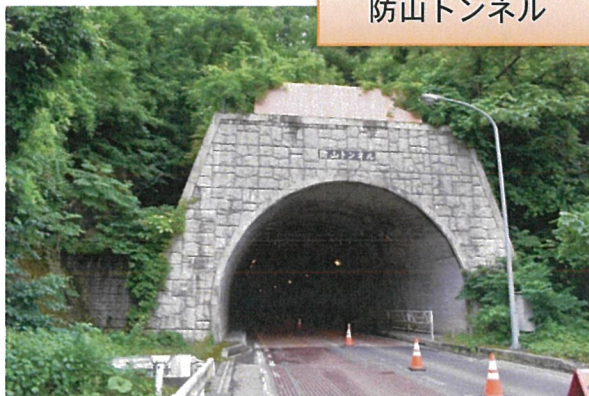
防山トンネル
