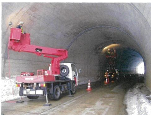
写真3.1 点検車による点検
