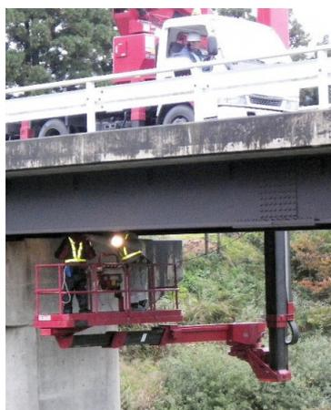
写真3.3 点検車による点検
