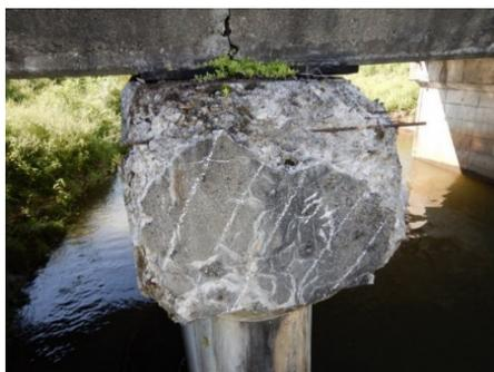
橋脚の遊離石灰を伴うひびわれ、剥離
