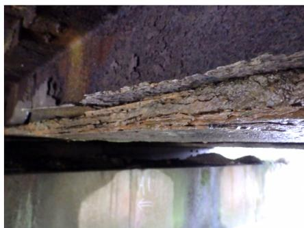
鋼桁の腐食
