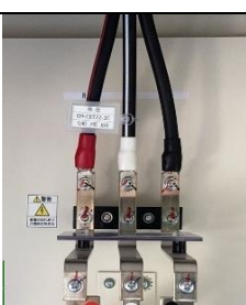
盤締付ダブルチェック
