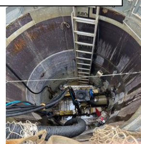
施工状況（推進工法）
