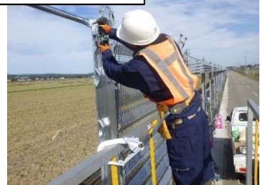
支柱を等間隔に設置するため作製した治具を活用した作業状況
