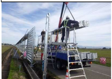
支柱を等間隔に設置するため作製した治具を活用した作業状況
