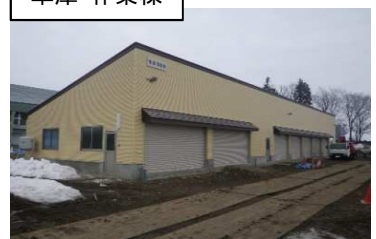
車庫・作業棟
