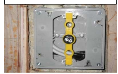
ボックス探知用磁石取付状況
