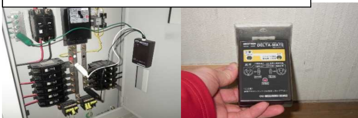
コンセント配線チェッカーで無電圧での配線調査を実施
