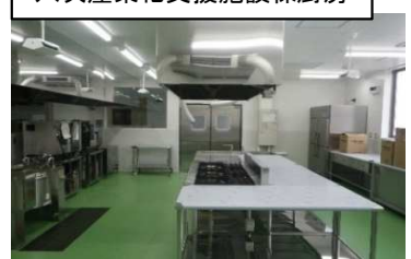
六次産業化支援施設棟厨房
