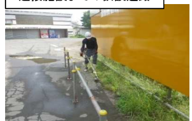
近接施設までの仮設通路
