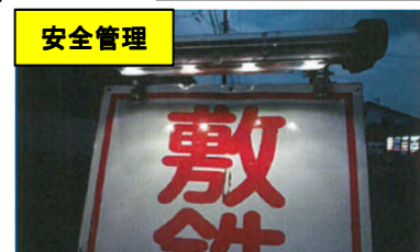
安全看板にエコモーションライトを設置
