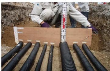
地中埋設配管の離隔ゲージ
