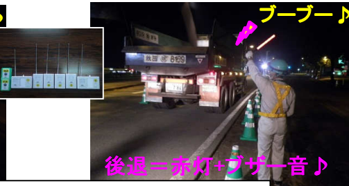
ワイヤレスチャイムと2色誘導棒によるダンプの誘導
