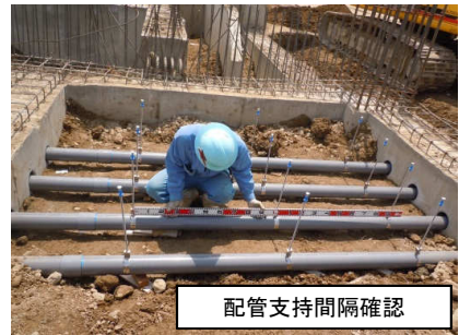
屋外配管の沈降防止
