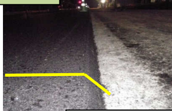
面取舗装枠による打ち継ぎ目密着性の確保
