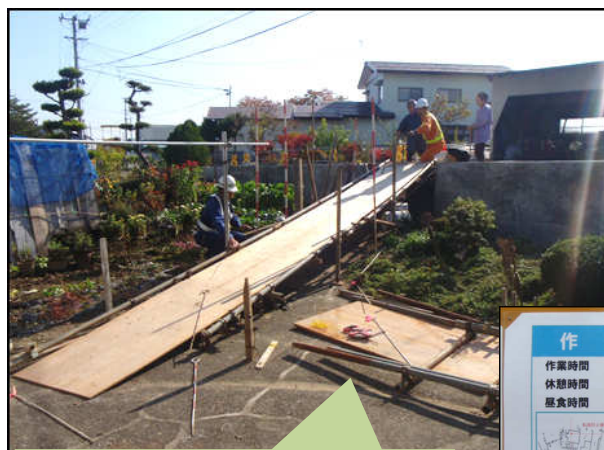
宅地への取付道路を仮設通路を設置し実際に歩いてもらい勾配について、住民(高齢者)と協議した。
