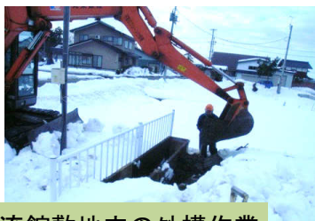
交流館敷地内の外構作業
