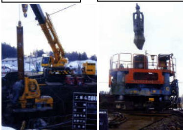
仮締切工 (WJ併用油圧圧)
