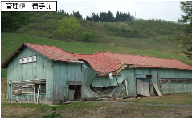
管理棟 着手前
