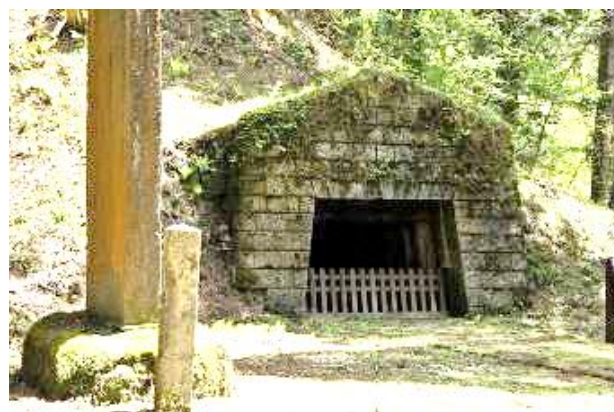
→ 院内銀山跡・御幸坑
