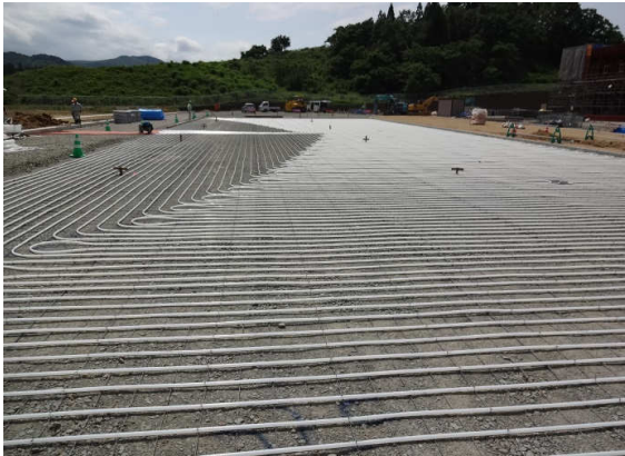
融雪パイプの埋設状況
