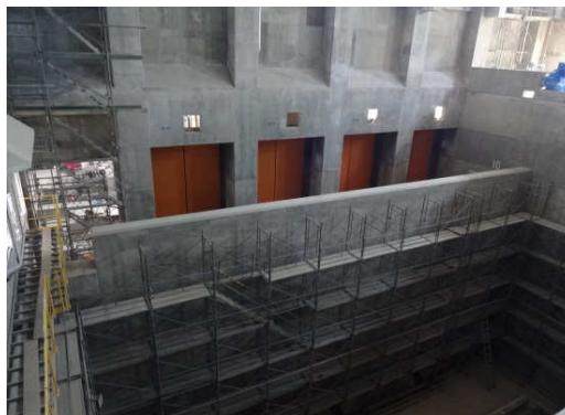
ごみピット側（裏側）から撮影した投入口
