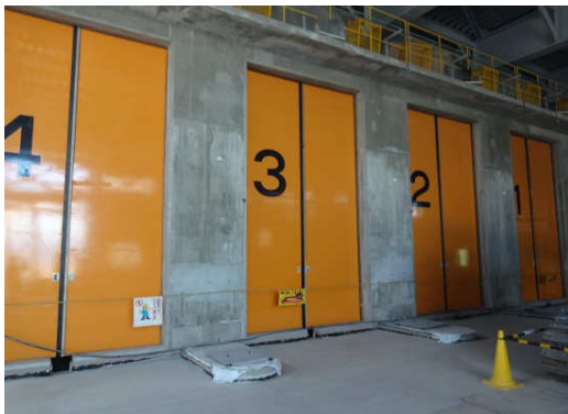
ごみ投入口に自動開閉扉が付きまして
