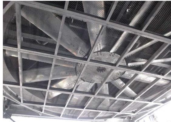
三角屋根のように6基のフィン付伝熱管が並びます。フィン付伝熱管1基は、128本の伝熱管で構成されています。
