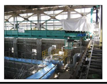
左写真…ごみピットに投入されたごみは、一定の燃え方になるように、ストーカ炉に投入する前に均一にかき混ぜる必要があります。 そのため、ごみをつかむごみクレーンが必要になります。
