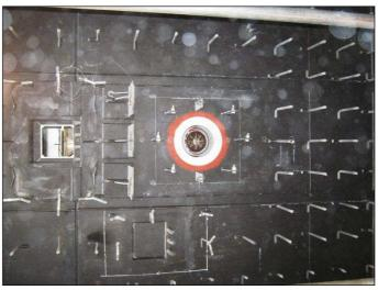
左上写真…ストーカ炉内部を覆う耐火レンガ、モルタル等の材料受入検査が行われました。 右上写真…施工前のストーカ炉内部の様子。レンガやモルタルを壁面に貼り付けるためのスタッド(壁面から突き出した I 字型や Y 字型の金属)がむき出しの状態です。検査を経た材料がストーカ炉内に運び込まれ、断熱工事が行われています。
