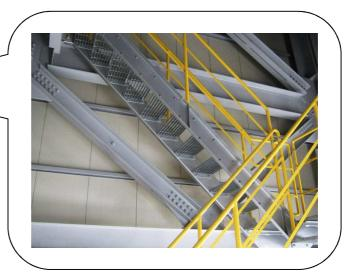
熱回収施設の外壁にはセメントが材料の「アスロック」という外壁材が使われています。一方、煙突部はこれに比べ白い外壁となっています。これはスチール製の中空構造の外壁材で、「アスロック」に比べさらに軽く、表面に凹凸が少なく、汚れが付きにくい材料となっています。景観に配慮し、風景に溶け込むような設計となっています。右上写真は、煙突内部から外壁材が貼り付けられた様子を撮影しました。
