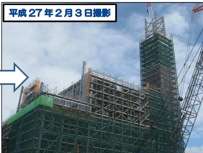
煙突の枠組みとなる鉄骨がほぼ組み上がりました。この後、煙突本体の筒部分が吊り上げられ、上から挿入されます。59メートルもの高さに達する煙突ですから、10メートルほどの部材ごとに組みつけられていきます。
