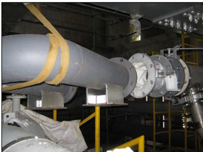
熱回収施設内部では、ダクト配管工事とその他機器据え付け工事が行われています。
