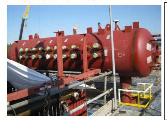
熱回収施設の発電設備のひとつであるボイ ラーが設置されました(パノラマ写真①施設 最上部にて撮影)。
