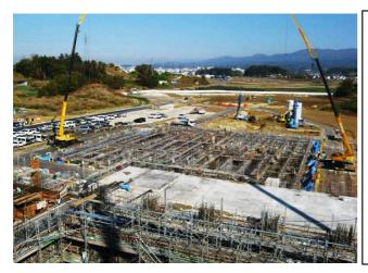
パノラマ写真の②部分を撮影しました。リ サイクルセンター建設地の柱状改良が終わり、 基礎工事を行っています。リサイクルセン ター本体工事及び機器の搬入据え付け工事は 平成27年度に行う予定です。
