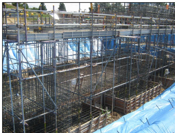
機械設備設置のため約4.3m掘削されました
