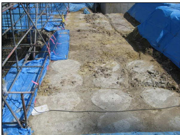
地中にコンクリートの柱を築き、地盤が強化された様子
