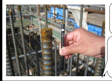
基礎を作るための 鉄筋は、非常に高い 密度で組み上げられ ています。
