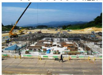
6月上旬現在、クリーンプラザよこて工事現 場では、熱回収施設の基礎工事が行われており ます。流し込んだコンクリートが固まり、型枠 や足場が取り外され、徐々に構造物としての姿 を現し始めました。
