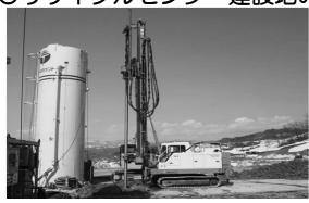
現在基礎工事が進んでいる熱回収施設の北側、リサイクルセンター建設地の地盤改良が6/16から始まります。『建設工事だより 第6号』でお知らせしたものと同様の「柱状改良」という施工法が用いられます。
