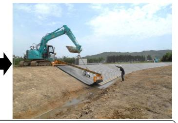
防災調整池工事の進み具合。左写真は5月上旬、右写真は6月上旬。コンクリート製の護岸 シートが整然と貼り付けられていきます。
