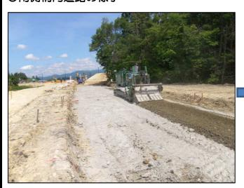
6月24日撮影 スタビライザーと呼ばれる機械。土とセ メントをかき混ぜて地盤を改良します。
