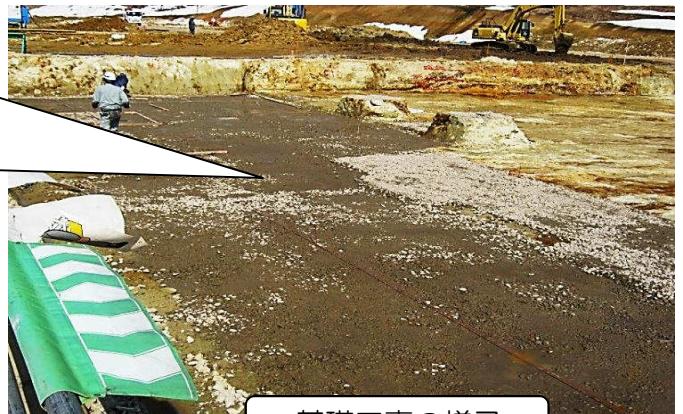
基礎工事の様子
