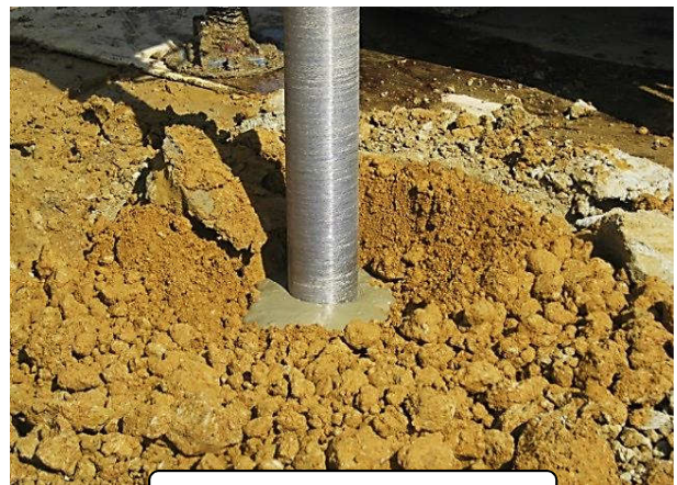
セメント注入の様子
