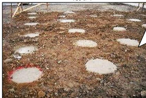
施工後の地面はこのようなになります。工事により埋め込まれたセメント柱の上に基礎工事を行うことで地盤の沈下を防ぎ、より安全な施設の建築が可能となります。
