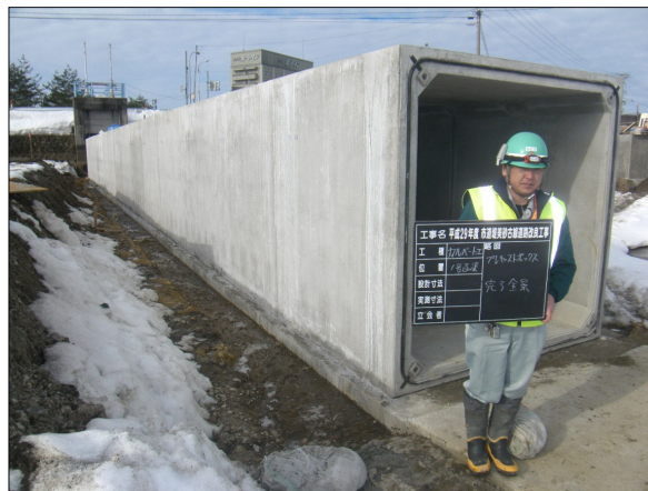
ボックスカルバート工 1号函渠 敷設完了
