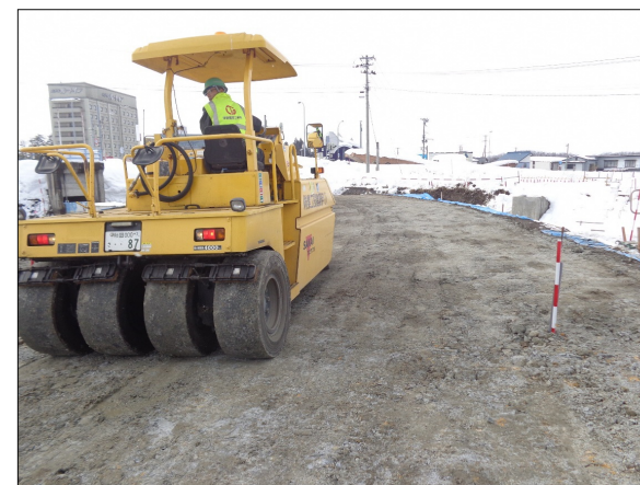
道路土工 路体盛土 転圧状況
