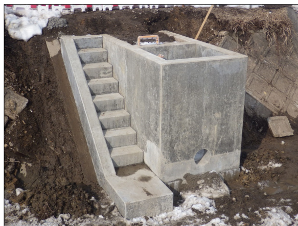
取水口 現場打ち水槽・翼壁工・階段工
