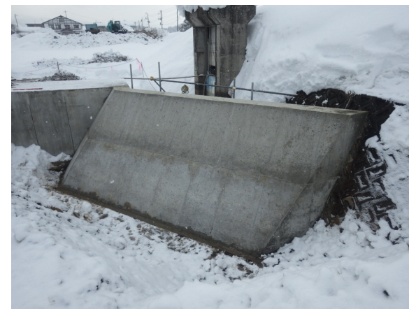
擁壁工 打設完了
