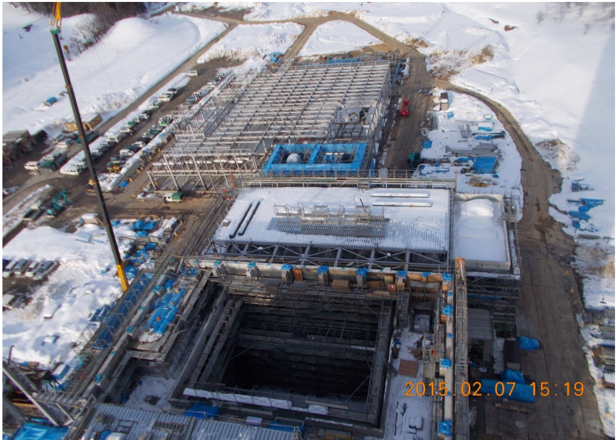
煙突から見た様子(上側:リサイクル施設、下側:熱回収施設)
