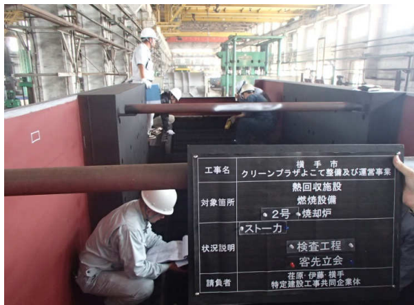
焼却炉の工場立会検査の様子 (H26/7月 中国 青島市にて)
