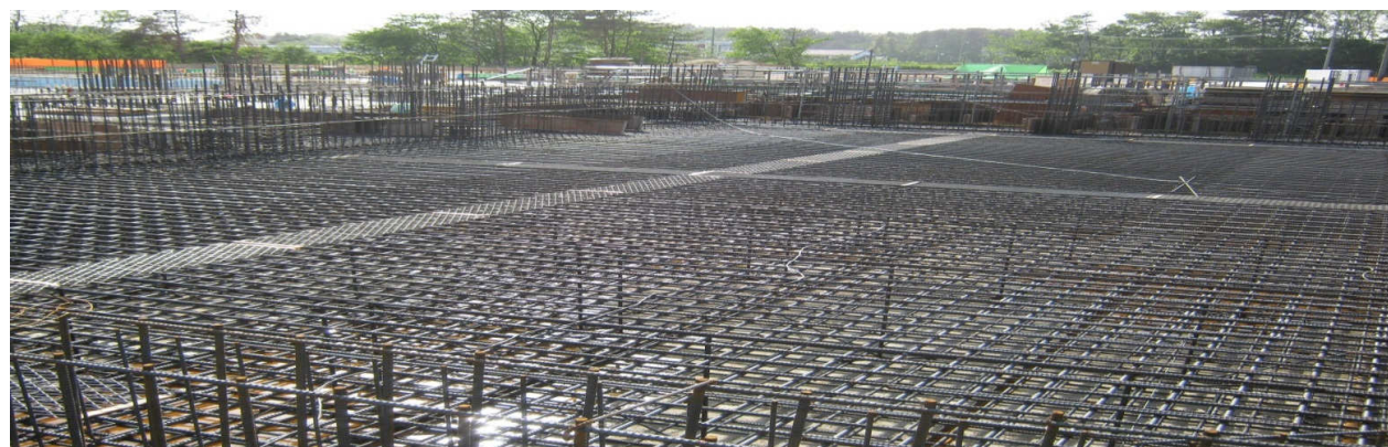
格子状に組まれた配筋の様子
