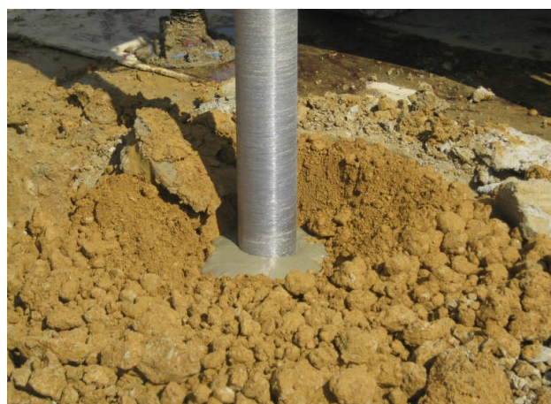
回転しながらセメント注入の様子
