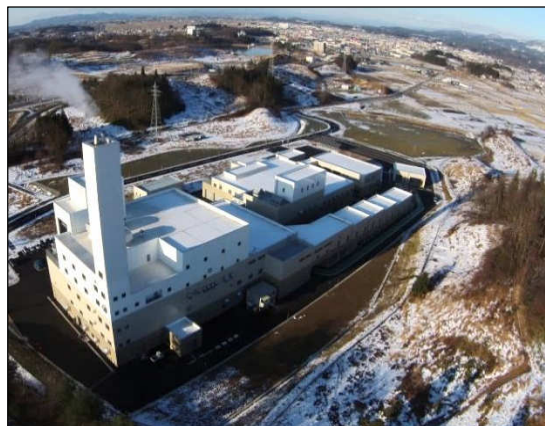
クリーンプラザよこて
