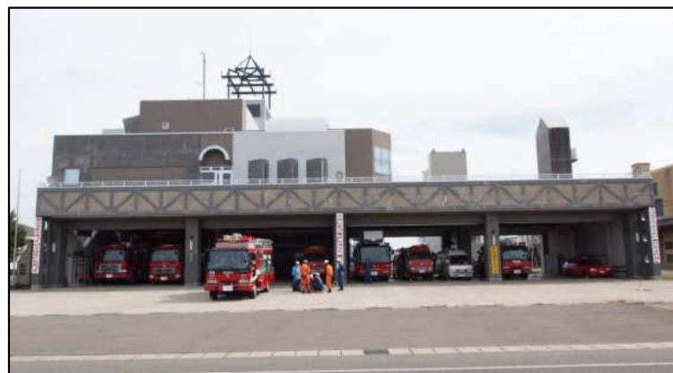
条里北庁舎 (消防本部、横手消防署)
