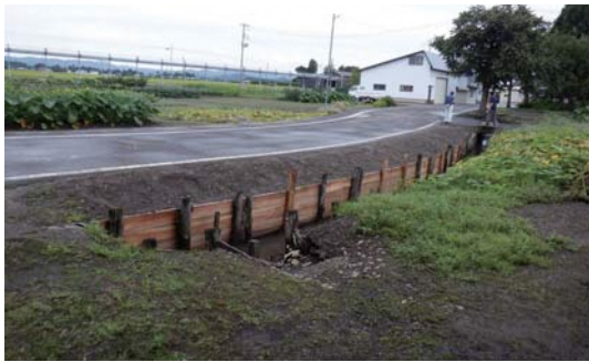
水路板柵の補修(八柏会館前水路)
